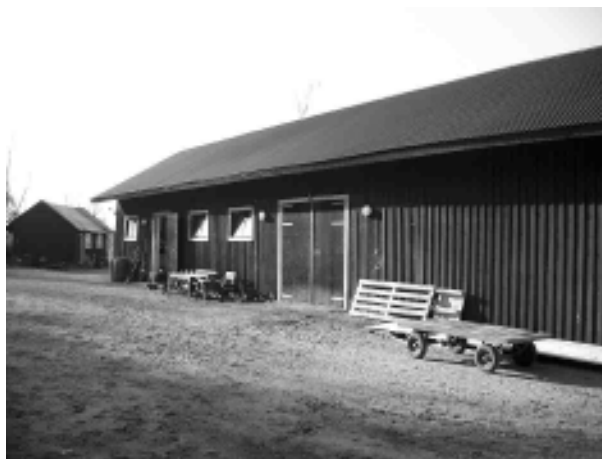
Maskinhuset vid Skalunda som stall.
