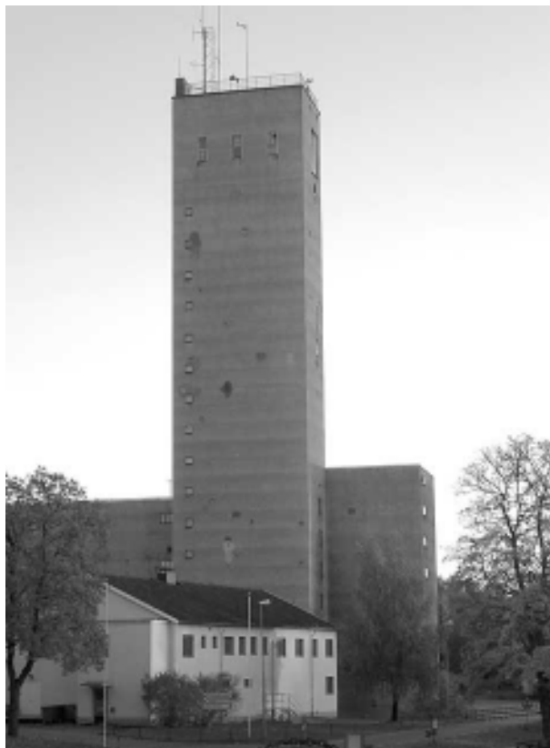
Den moderna anläggningens gruvlave, utan lyftbalkar.
