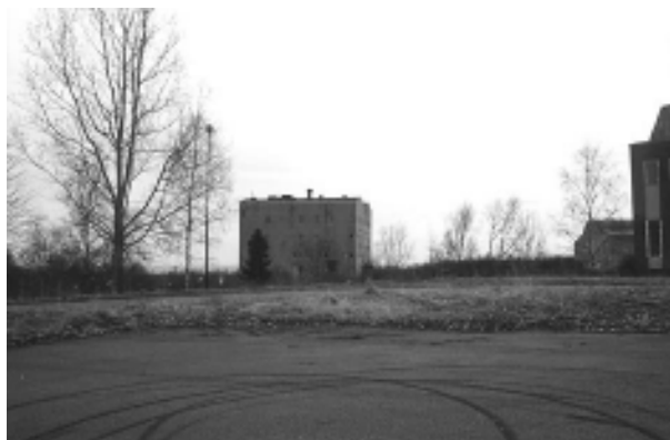
Kulsinterverket utan utlastningsfickor (tidigare t.v.).
