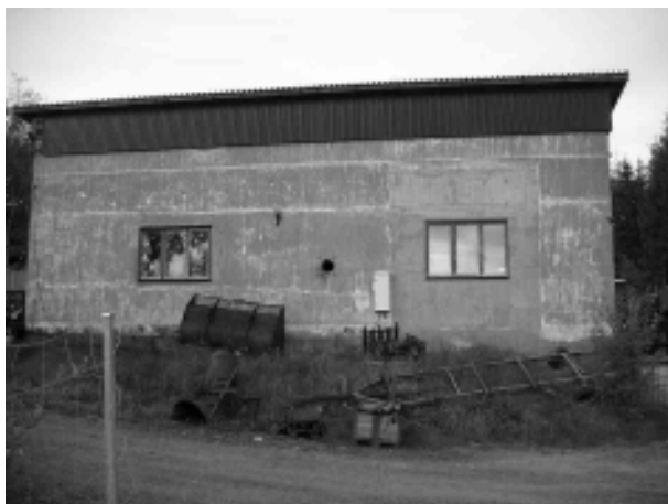
Det f.d. maskinhuset.
