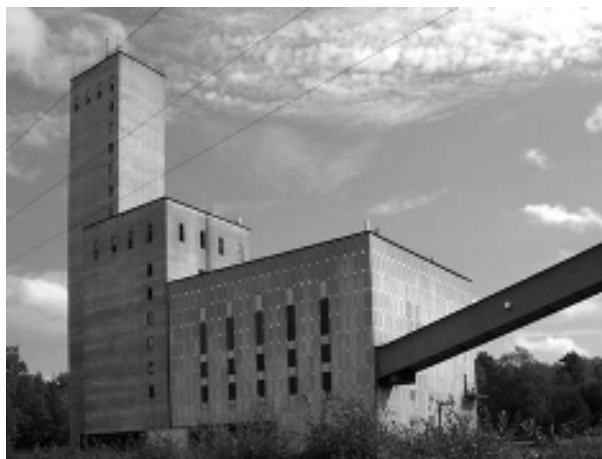
Anriktningsverket vid Mimer med säkrad fasad.
