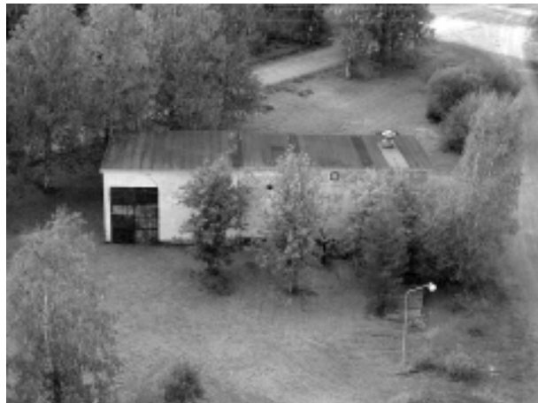
Det gamla maskinhuset vid Sköttgruvan.
