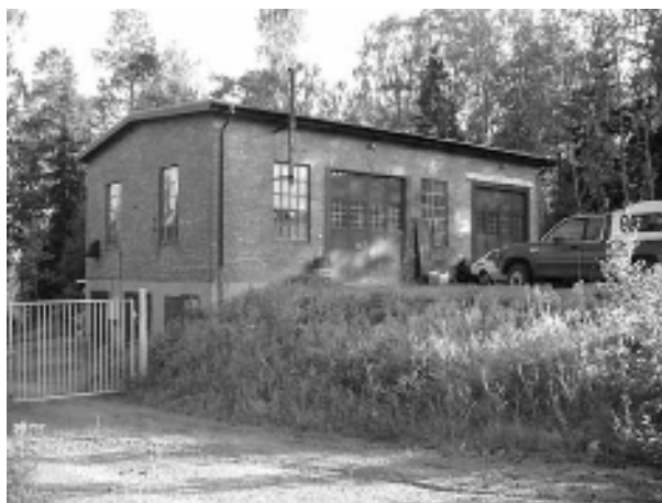
Det ombyggda maskinhuset vid Nyängsgruvan.
