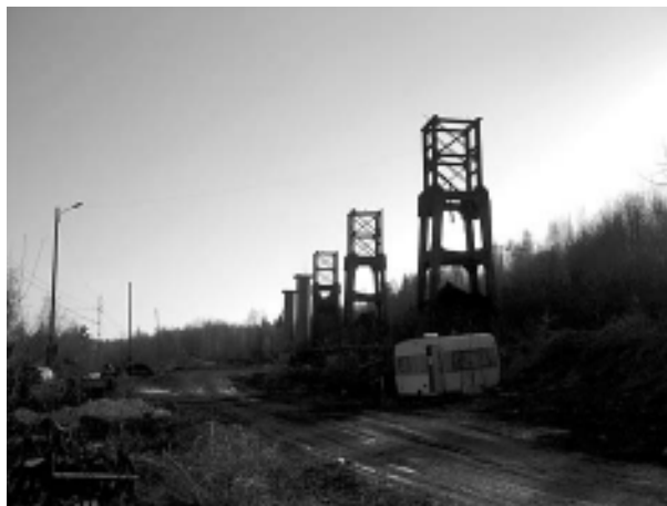
Pelarna som bar upp utfraktsbanan.
