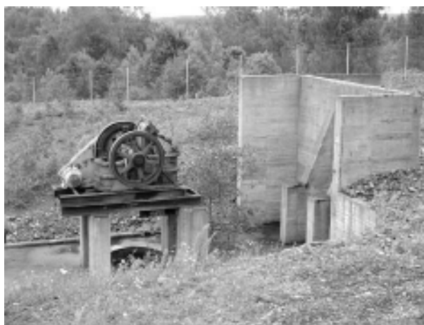
Blake-krossen i den rivna anläggningen vid Storgruvan.
